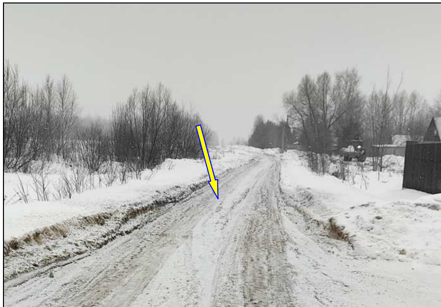
Рисунок П.1 – Фрагмент существующей а/дороги по ул. Дружба
